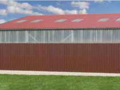
Dach Wellfaserzement, Lichtplatten, Lichtband „natur-transparent“, Trapezblech
